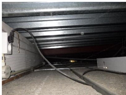
Boven verlaagd plafond geen asbestverdacht materiaal
