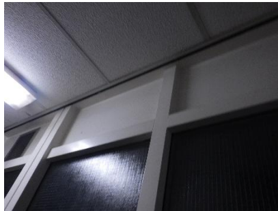
Board niet asbestverdacht
