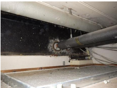
Stalen balken niet asbestverdacht
