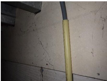
Brandwerende beplating niet asbestverdacht
