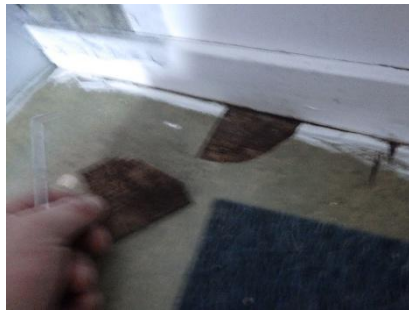
Onder linoleum geen asbestverdacht materiaal
