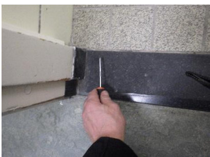
Dorpel niet asbestverdacht
