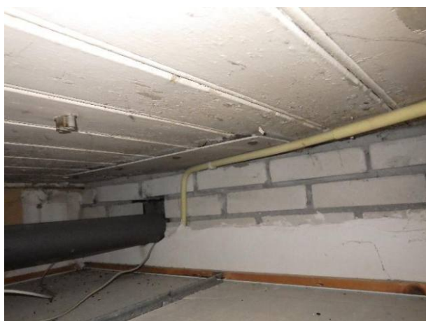
Bron 1 Vlakke plaat loopt door boven muur (2)
