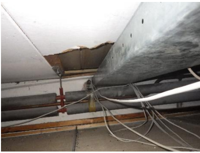
Leidingisolatie niet asbestverdacht
