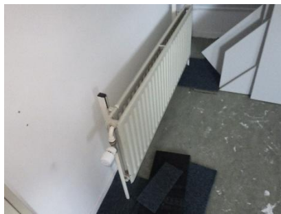
Radiatoren niet asbestverdacht
