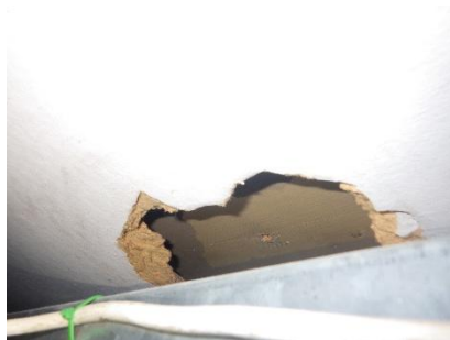
Zachtboardplafonds niet asbestverdacht, beperking erboven
