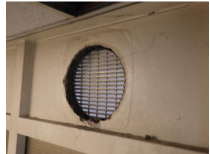
Board niet asbestverdacht
