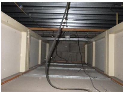
Board boven plafond niet asbestverdacht
