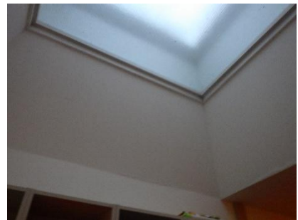
Beperking boven verlaagd plafond en bij lichtkoepel
