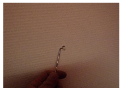
Gipswanden niet asbestverdacht, beperking erachter
