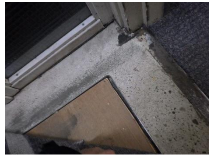
Onder vloerbedekking geen asbestverdacht materiaal
