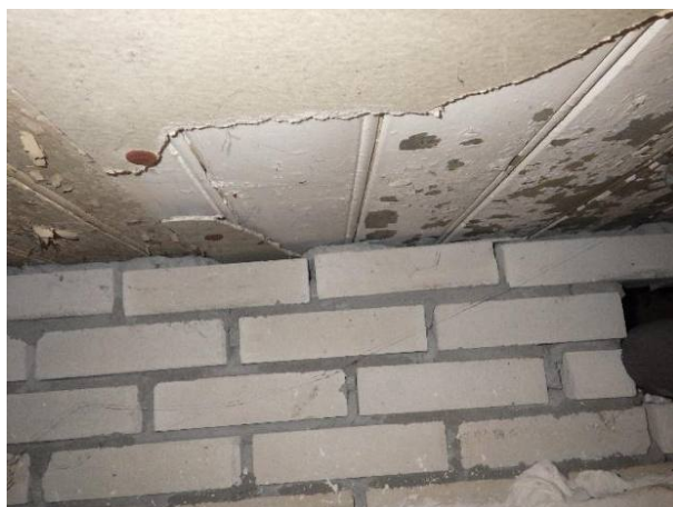
Bron 1 Vlakke plaat loopt door boven muur
