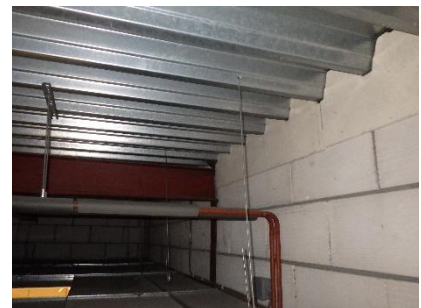
Brandwerende beplating bij opslag niet asbestverdacht
