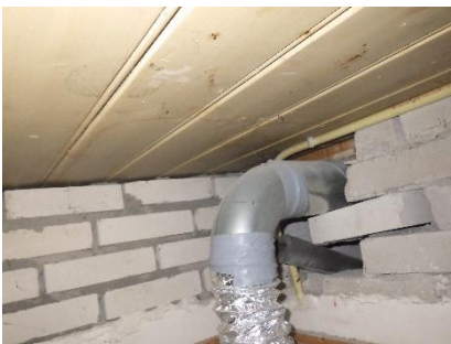
Ontluchting toiletten niet asbestverdacht
